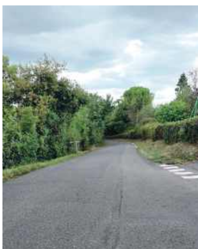
Route des Fontaines
