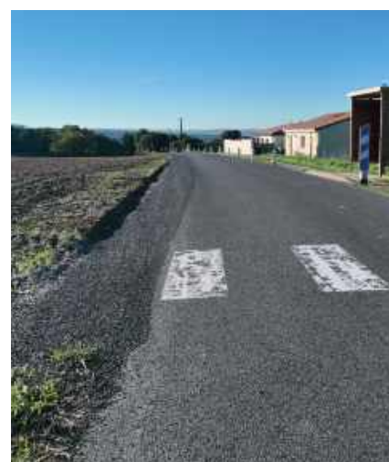
Route des Fontaines (poutres)
