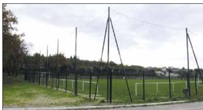
Installation de grillages et filets au terrain de foot d'entraînement.
